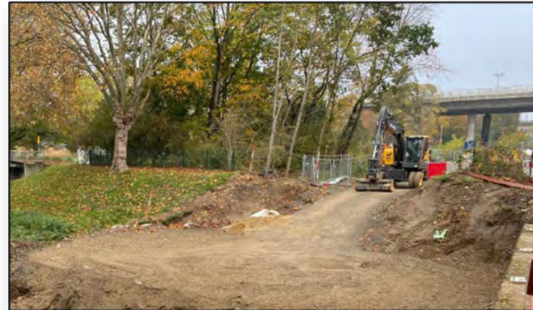
- Herstellung von Baustraßen
