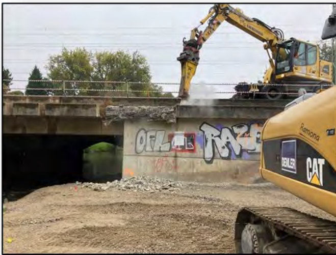
- Abbruch der Brückenkappe
